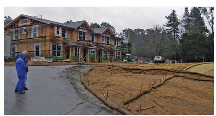
**EROSION CONTROL MEASURES WORK BEST WHEN INSTALLED PRIOR TO THE RAINY SEASON**
