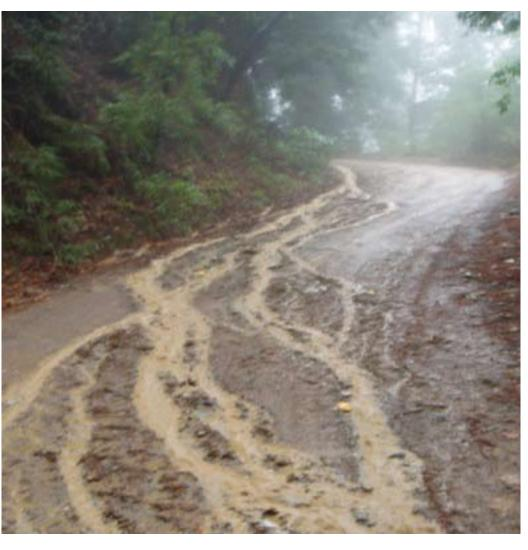
ROPER DRAINAGE ON DIRT ROADS CAN PREVENT **EROSION AND REDUCE MAINTENANCE COSTS**
